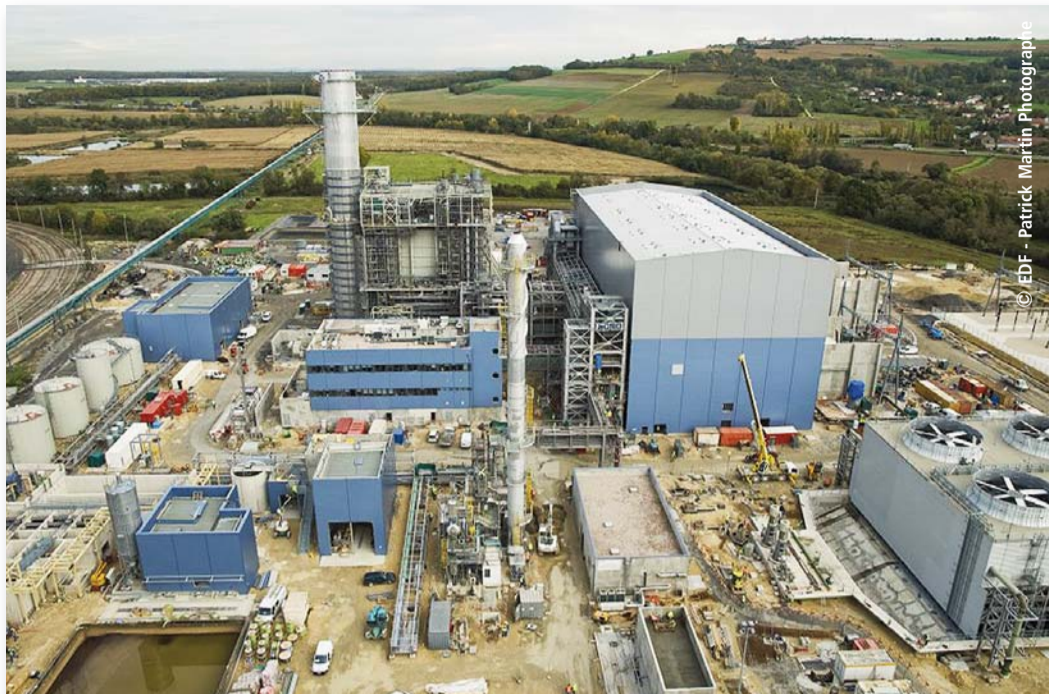
Le chantier génère environ 250 emplois pendant les 2 ans et demi de sa durée.
